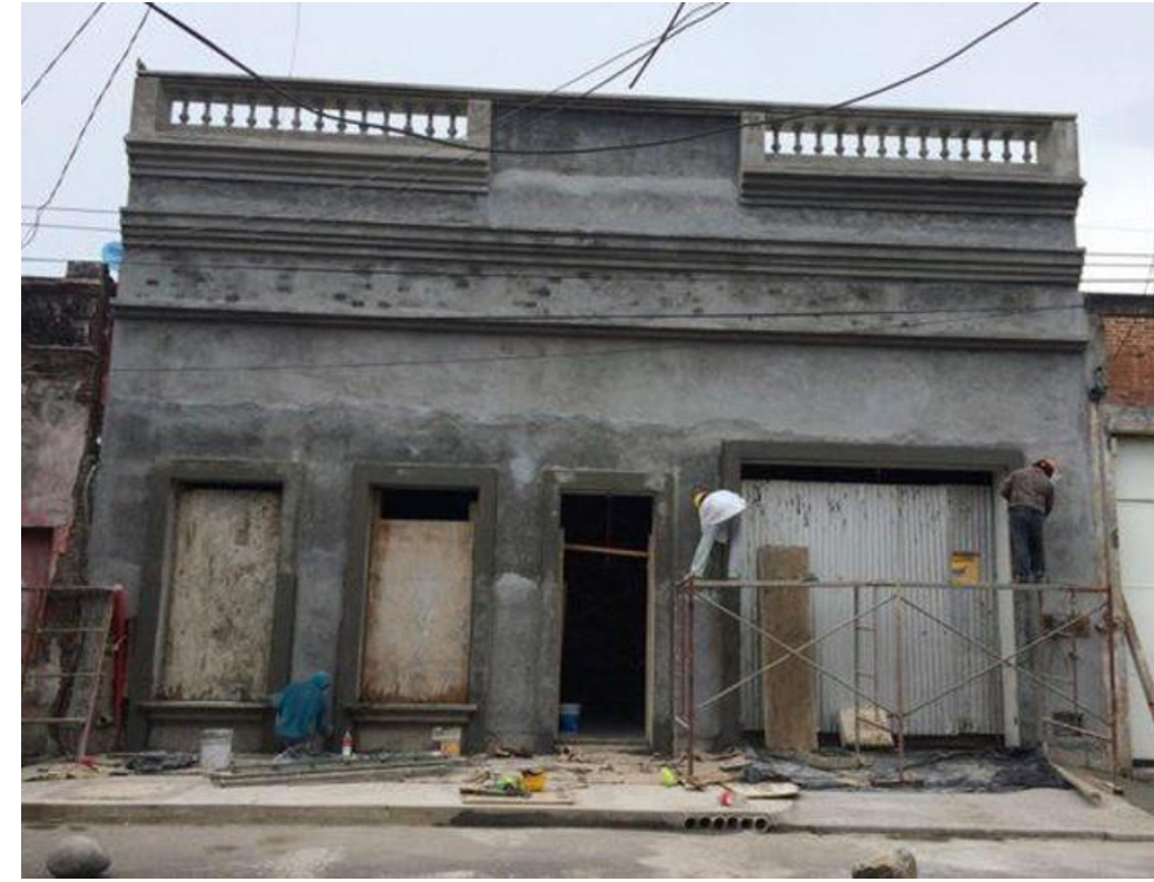
PROCESO DE CONSTRUCCIÓN
